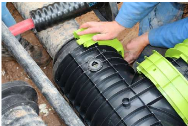
Abb. 3: Montage HeatClick Muffe im Bestand (Verschlussring)
