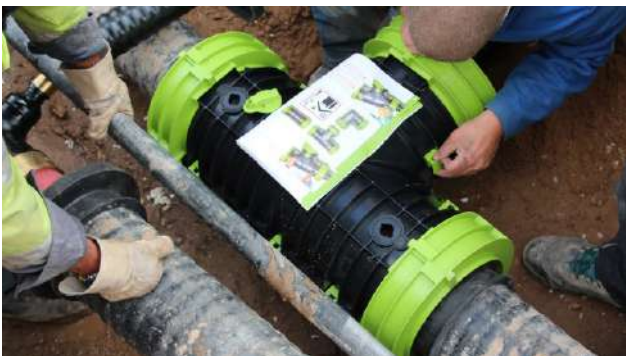
Abb. 5: Montage HeatClick Muffe im Bestand (Einsteckclip)
