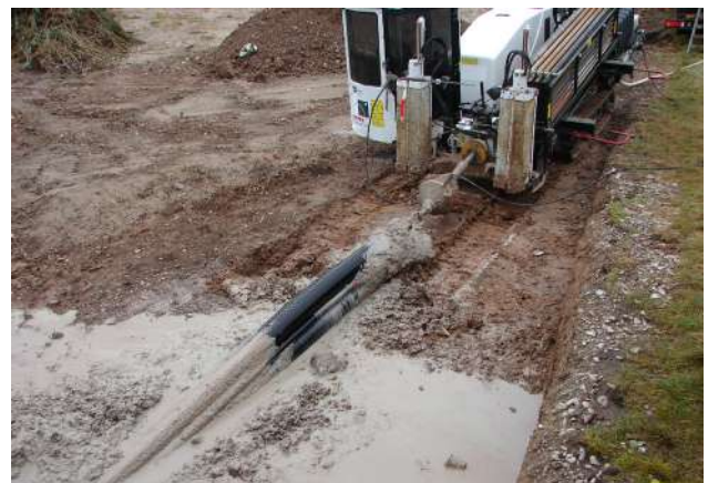
Abb. 29: Spülbohrgerät mit Rohren in der Startgrube
